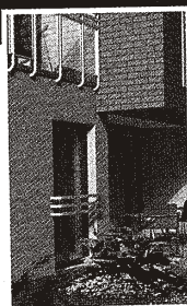
Ludwinowska Aleja. Osiedle w trakcie budowy, przy ul. Ludwinowskiej w Pyrach, na skraju warszawskiego Ursynowa. Zaprojektowane w stylu modernistycznym.
